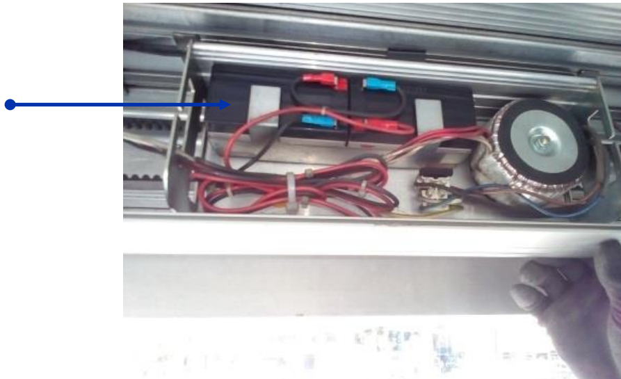
Figura 112. Vista baterías y convertidor de voltaje
