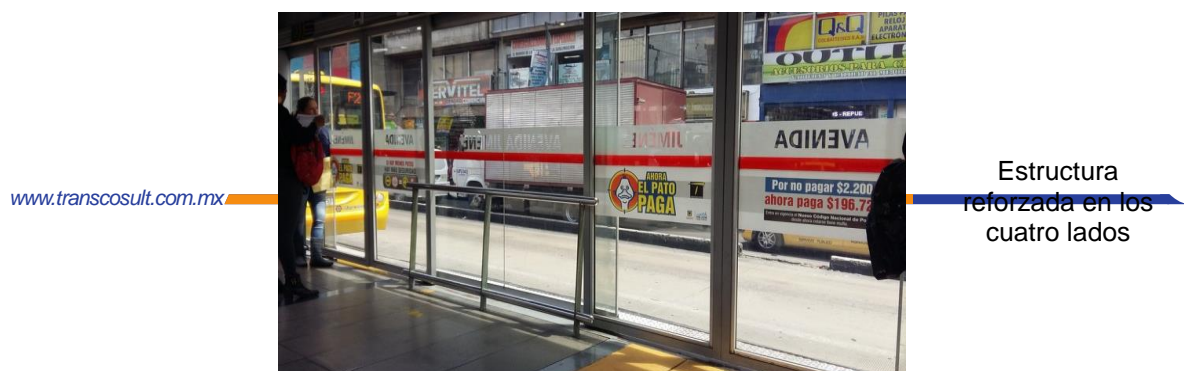
Figura 122. Vista interior de puertas en estación con reforzado en marcos
